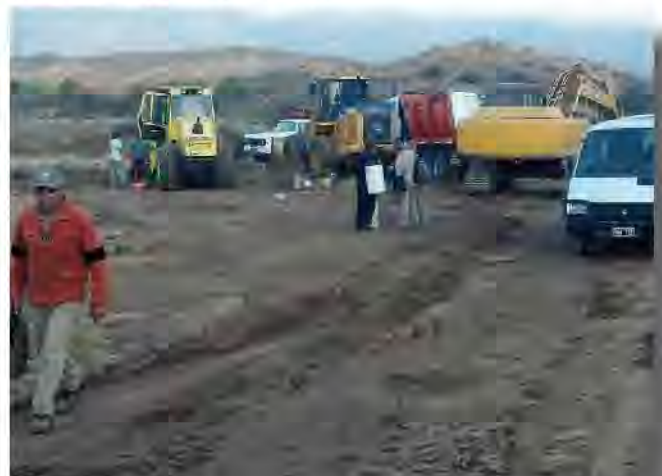
Imagen de la construcción de la planta de tratamiento cloacal que se encuentra a 7 kilómetros de nuestra localidad por el camino al Portezuelo.
